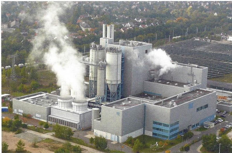
Das HKW Cottbus betreibt unter anderem eine Gasturbine, die bei aktivem Kohlekessel mit Rauchgas betrieben wird.
